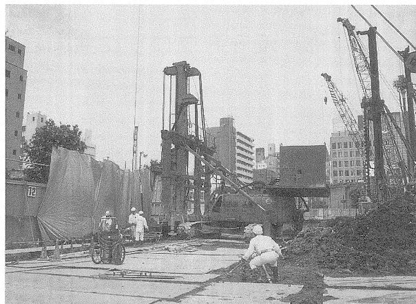
写真-2 トレーダー機による山留壁施工状況
