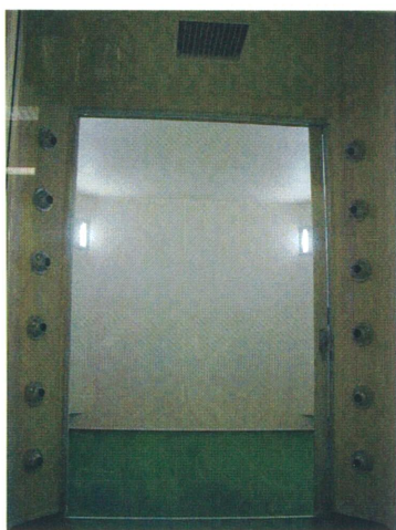
写真-1 試験室前室のエアシャワー
