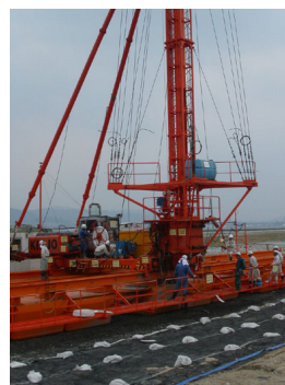
フロート式打設機
